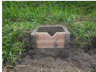
上部をV字にカットして排水量を抑制した堰板(機能一体型の取組み)
