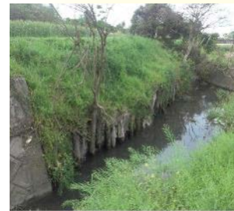
護岸整備 施工前
