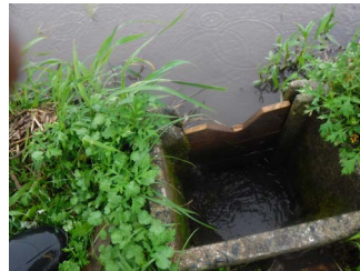
上部をV字にカットして排水量を抑制した堰板(機能一体型の取組み)
