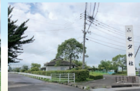
▲雨水貯留の調査・設計を行う大崎区のたなばた地域運動広場
