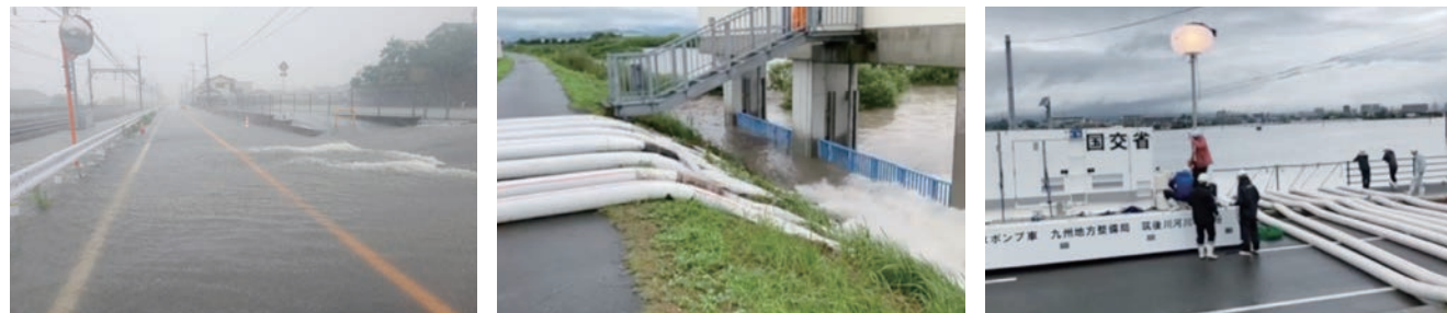
▲7/3の豪雨で溢れ出した内畑堤、市道は通行止めになりました。内畑堤はR6に浚渫の予定。 ▲7/10樋門閉鎖による内水氾濫対応のポンプ車排水 国・県のポンプ車2台が対応。
