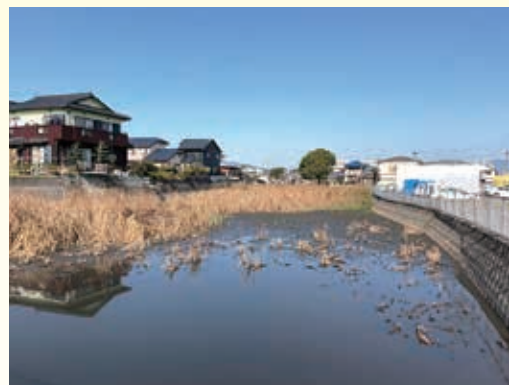
堆積土で貯水量（4,200m 3 ）が減少している内畑堤
