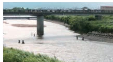
4月に県事業で撤去された旧端間橋下流にあった西福童堰
