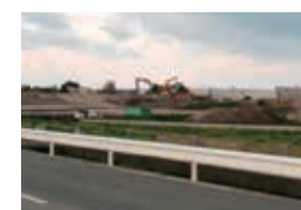
建設が進む味坂スマートIC(仮)治水対策が急務です
