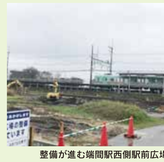
整備が進む端間駅西側駅前広場
