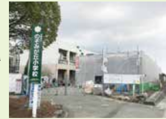
建設中ののぞみが丘小学校給食施設 民間委託で自校式給食がスタート
