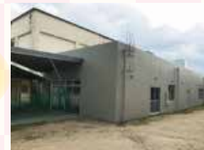
小郡小学校給食施設
