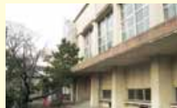
屋根改修工事中の小郡小学校体育館
