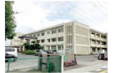
トイレ施設の全面改修が見送られた小郡中学校
