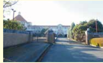
市役所の一部を仮移転する九州情報大学
