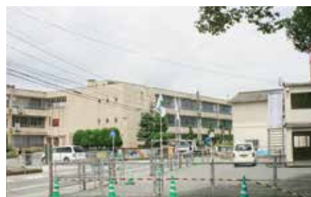
夏休み期間中に大規模改修がされる大原小学校
